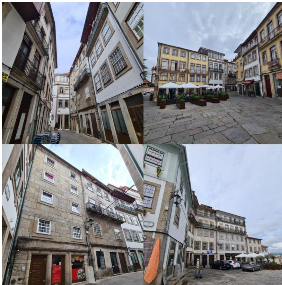
Figura 10 – Prédios do local de estudo.
