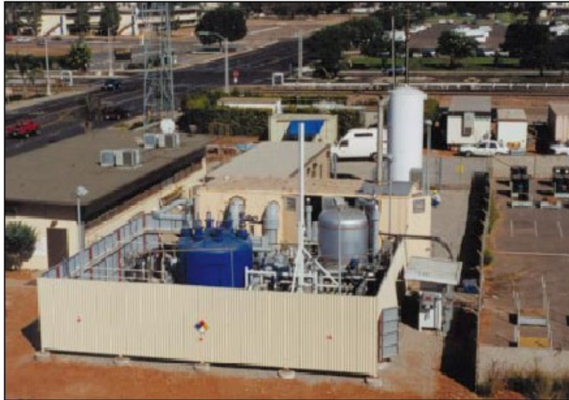
Figura 3.15 – Central eléctrica de 250 kW das forças armadas Norte Americanas usando a Pilha de Células de Combustível de Carbonatos Fundidos em San Diego na Califórnia.
