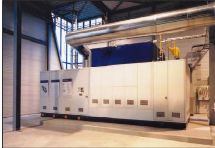
Figura 3.16 – Sistema de geração de 100kW funcionando nos Países Baixos baseado na tecnologia de Óxidos Sólidos da Siemens Westinghouse FONTE: http://www.fetc.doe.gov
